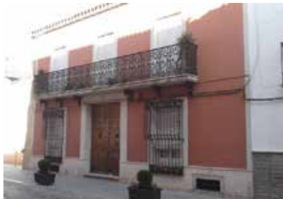
Casa de la calle Reyes Católicos, 11
