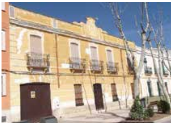
Casa del Paseo de la Estación, 15
