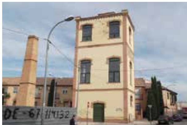
Torre y Chimenea de la Alcoholera Larios
