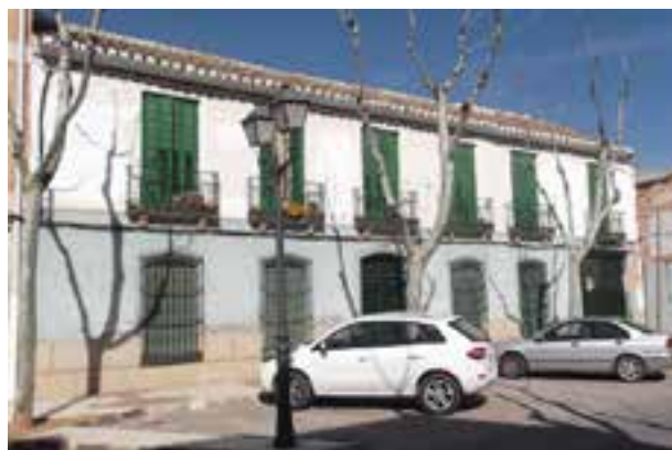
Casa del Paseo de la Estación, 21
