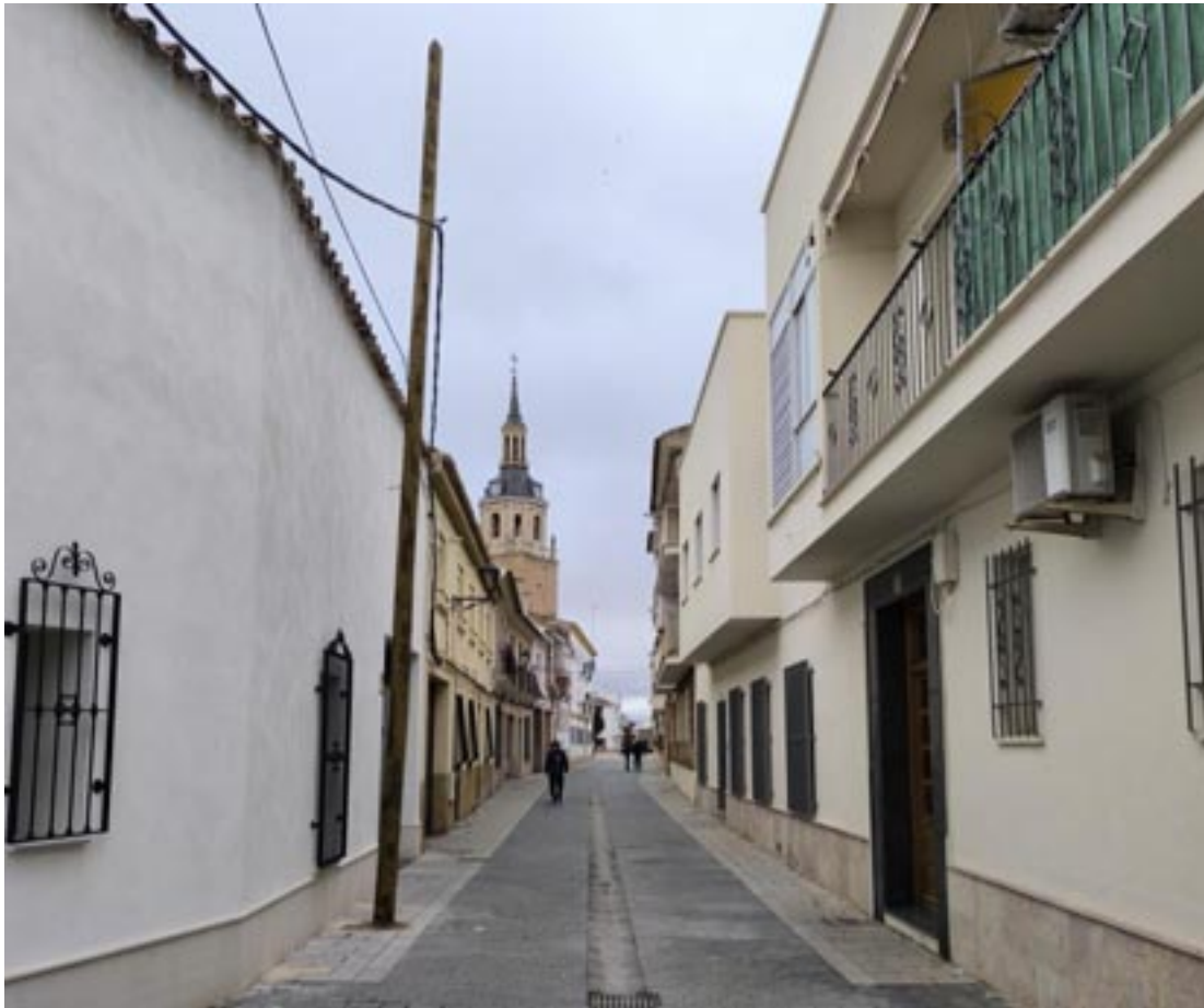
Calle de la Iglesia. Postes para cables, aparatos de aire acondicionado y voladizos ya no permitidos.
