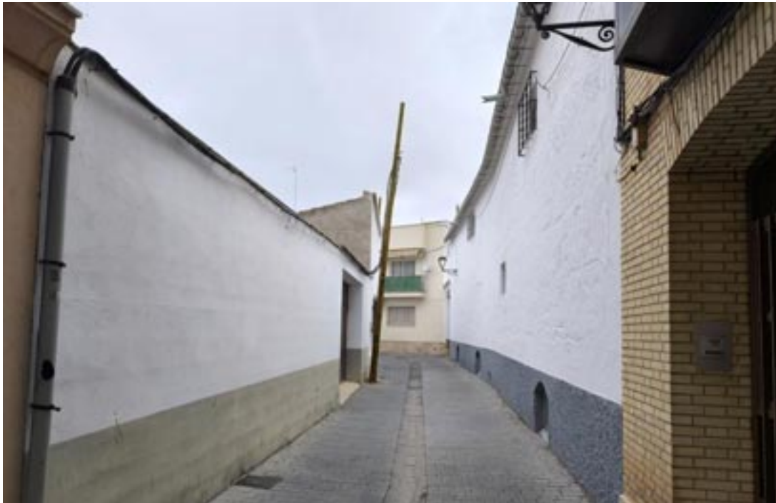
Tramo de calle de la Iglesia. En el lado izquierdo poste y elementos para cableado perturbadores.
