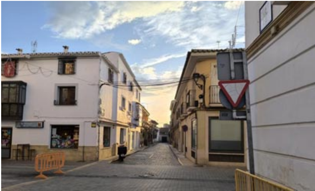
Inicio de la calle de la Hoz desde Calle Jesús del Perdón. Ubicación Puerta 2 de la muralla. Profusión de cableado de electricidad y de telecomunicaciones. Acerado estrecho no accesible
