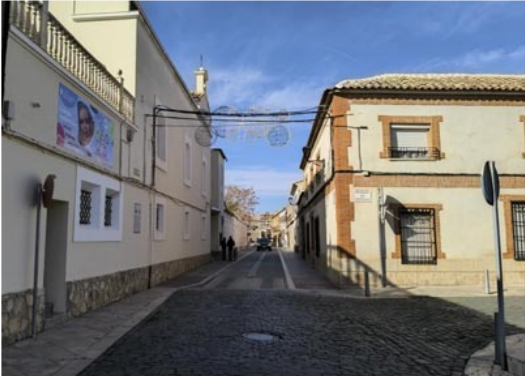
Calle del Carmen. Vista desde la Plaza del Castillo. Ubicación de la Puerta 1. Cableado aéreo que perturba la vista de la calle que en origen, fue la principal de Manzanares
