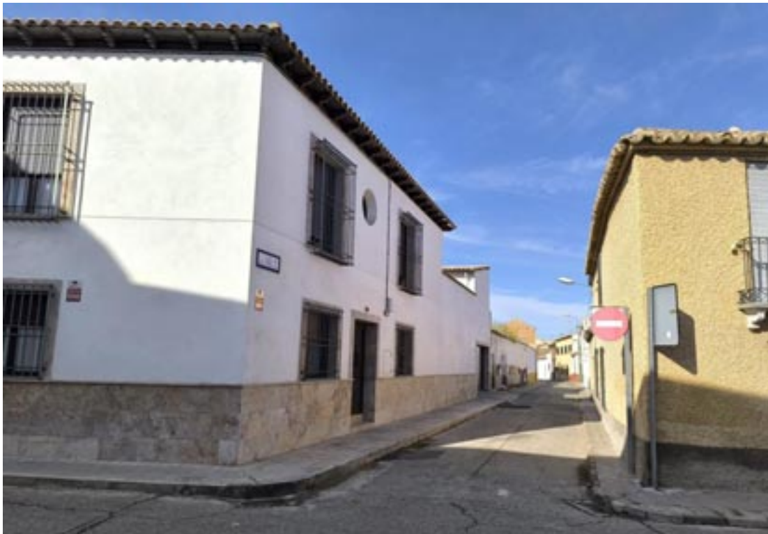
Esquina donde el frente de la muralla de la Plaza del Castillo, en el tramo de Calle La Prensa, inicia su recorrido por la calle Virgen de la Esperanza. Acerados muy estrechos y poco accesibles.
