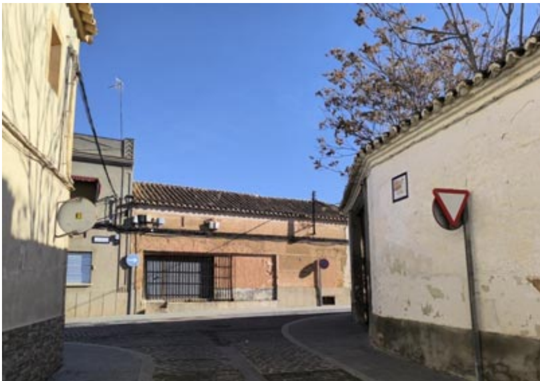
Encuentro de la calle Pizarro con calle Virgen del Carmen. Apoteosis de cableado y artefactos en fachadas.
